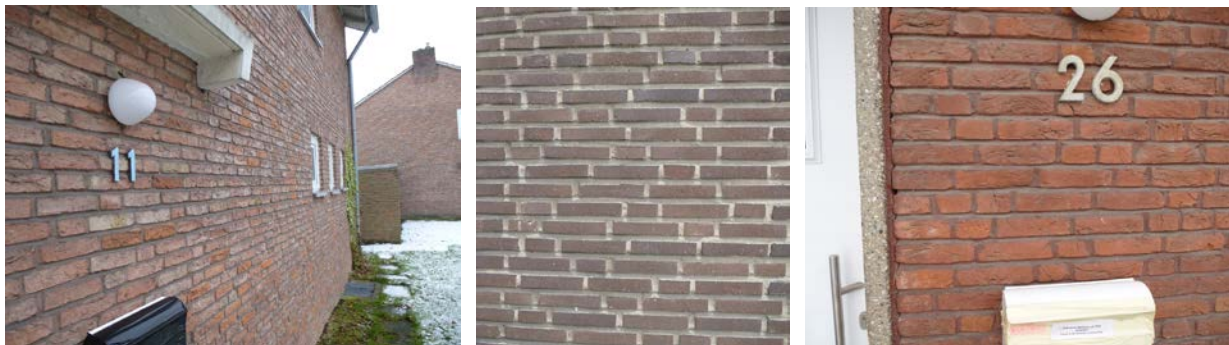
Abbildung 8: Fassaden im Bestand
