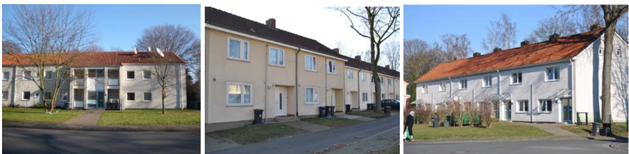
Abbildung 9: Prägende zweigeschossige Bebauung
